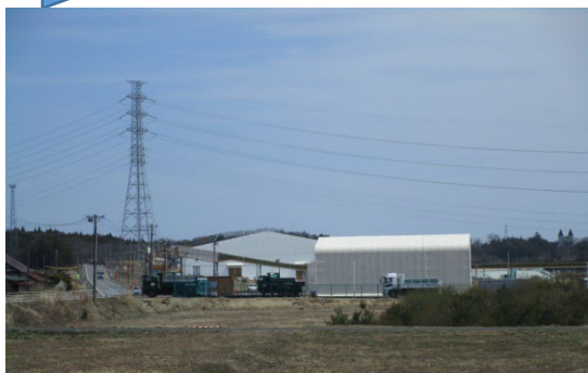
汚染された土を保管する中間貯蔵施設 (大熊町夫沢地区)
